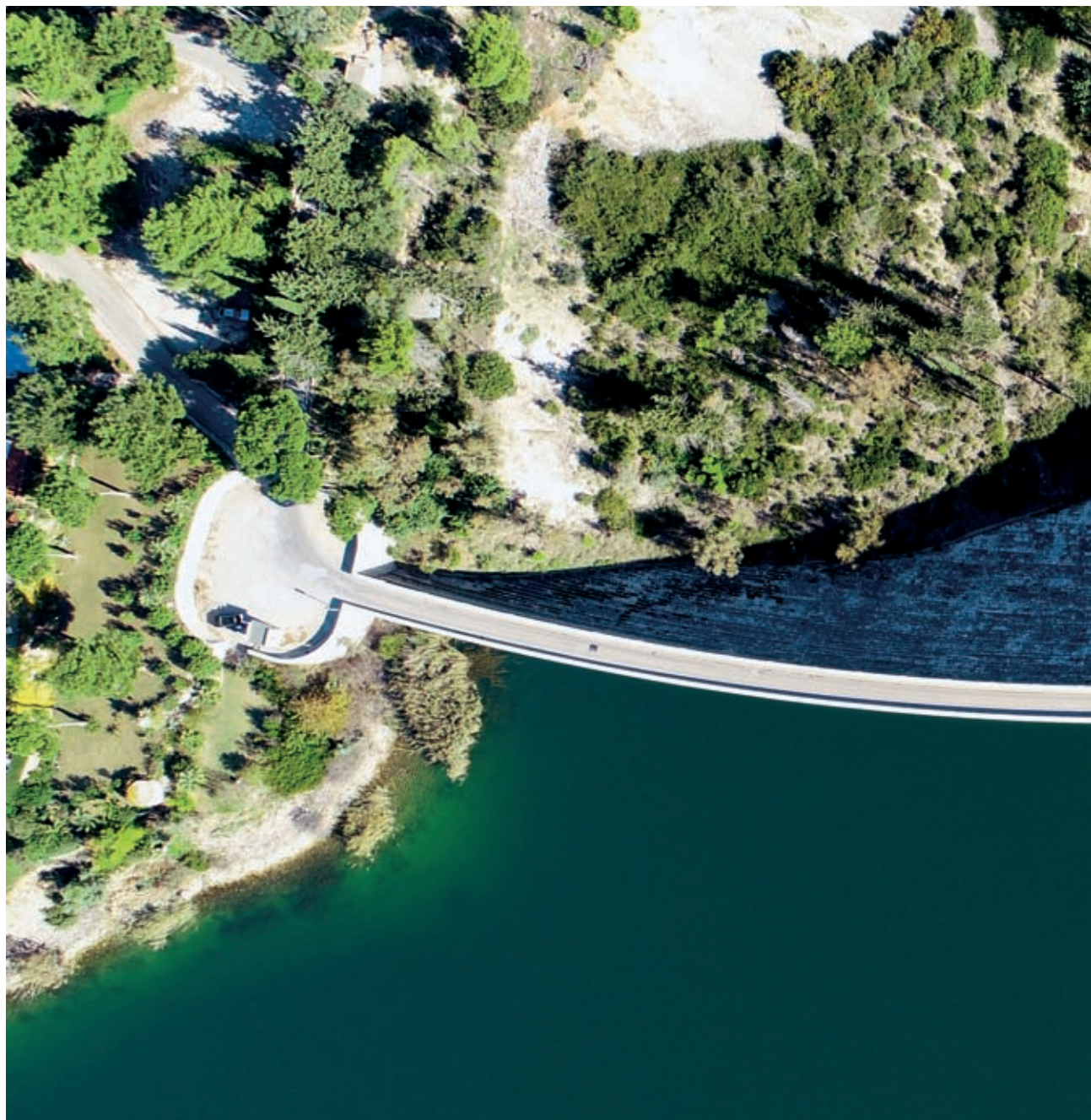
Φράγμα και τεχνητή λίμνη Μαραθώνα. Η τεχνητή λίμνη του Μαραθώνα αποτελεί τον πρώτο ταμιευτήρα του υδροδοτικού συστήματος Αττικής, καθώς και έναν σημαντικό υγροβιότοπο
