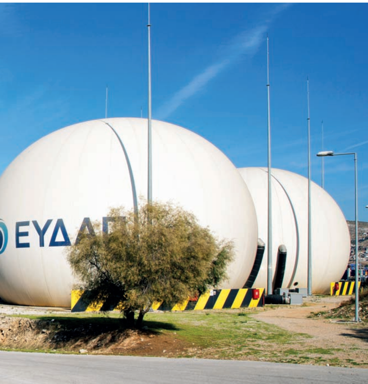
Αεροφυλάκιο βιοαερίου. Το σύνολο του βιοαερίου που παράγεται στους χωνευτές των ΚΕΛ της ΕΥΔΑΠ, αξιοποιείται ενεργειακά, χρησιμοποιούμενο ως καύσιμο σε διάφορες εργασίες των ΚΕΛ
