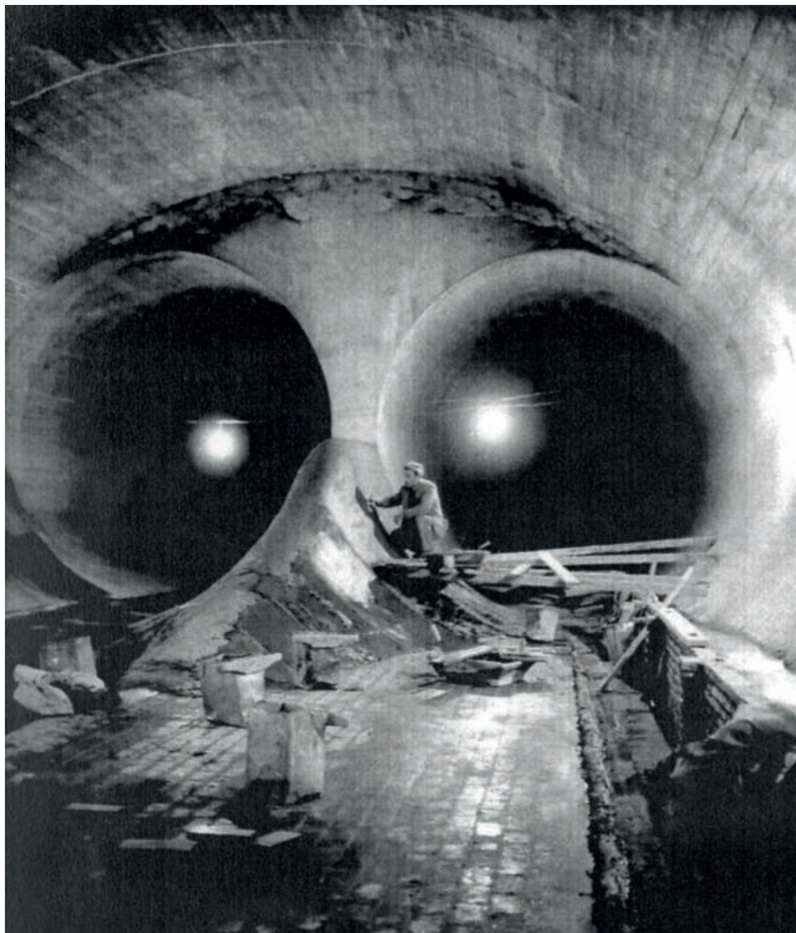
Δίδυμος αγωγός ακαθάρτων, 1940
