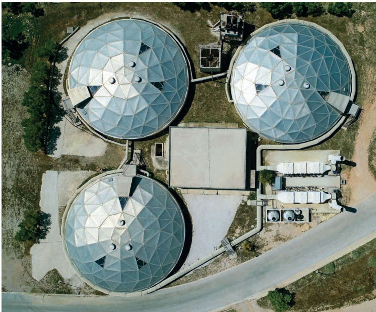
Δεξαμενές προπάχυνσης ιλύος του Κέντρου Επεξεργασίας Λυμάτων Ψυττάλειας. Στο ΚΕΛΨ γίνεται τριτοβάθμια βιολογική επεξεργασία και επεξεργασία της ιλύος. Το ποσοστό απομάκρυνσης ρυπαντικού φορτίου, σε όρους οργανικού φορτίου, είναι 93%
