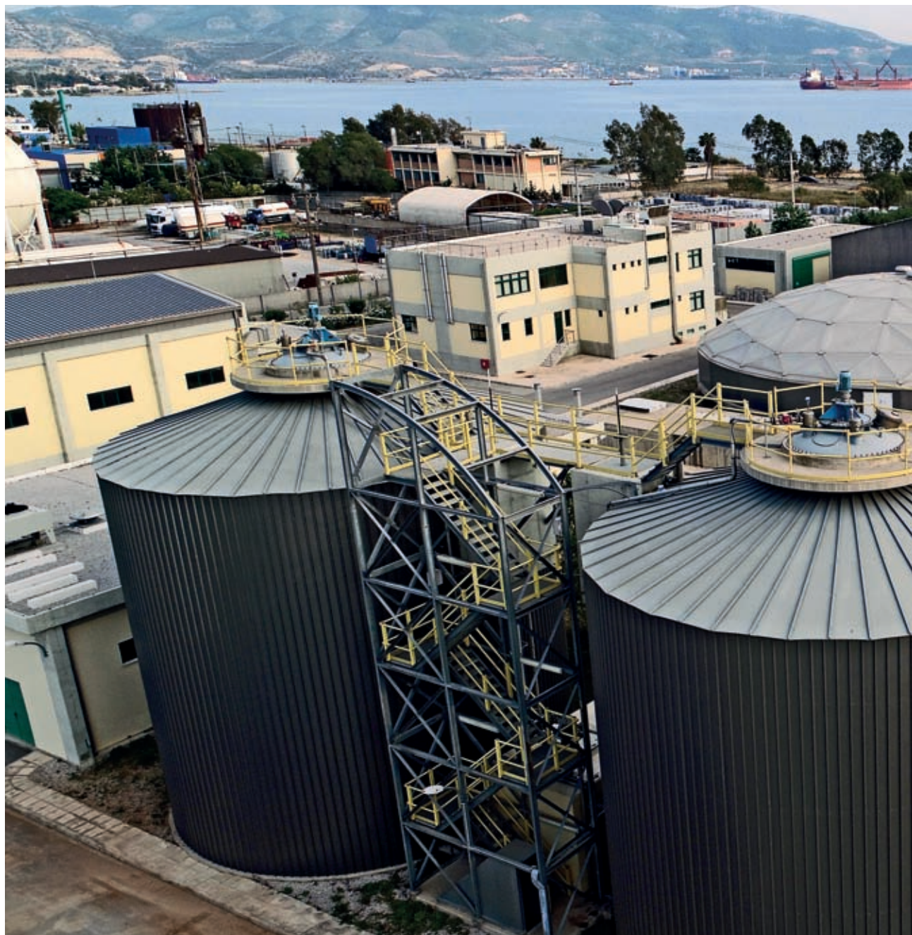
Εγκαταστάσεις Κέντρου Επεξεργασίας Λυμάτων Θριάσιου Πεδίου. Διακρίνονται οι Μονάδες χώνευσης ιλύος. Στο ΚΕΛΘ γίνεται τριτοβάθμια επεξεργασία. Επιτυγχάνεται απομάκρυνση του ρυπαντικού φορτίου σε ποσοστό άνω του 95%
