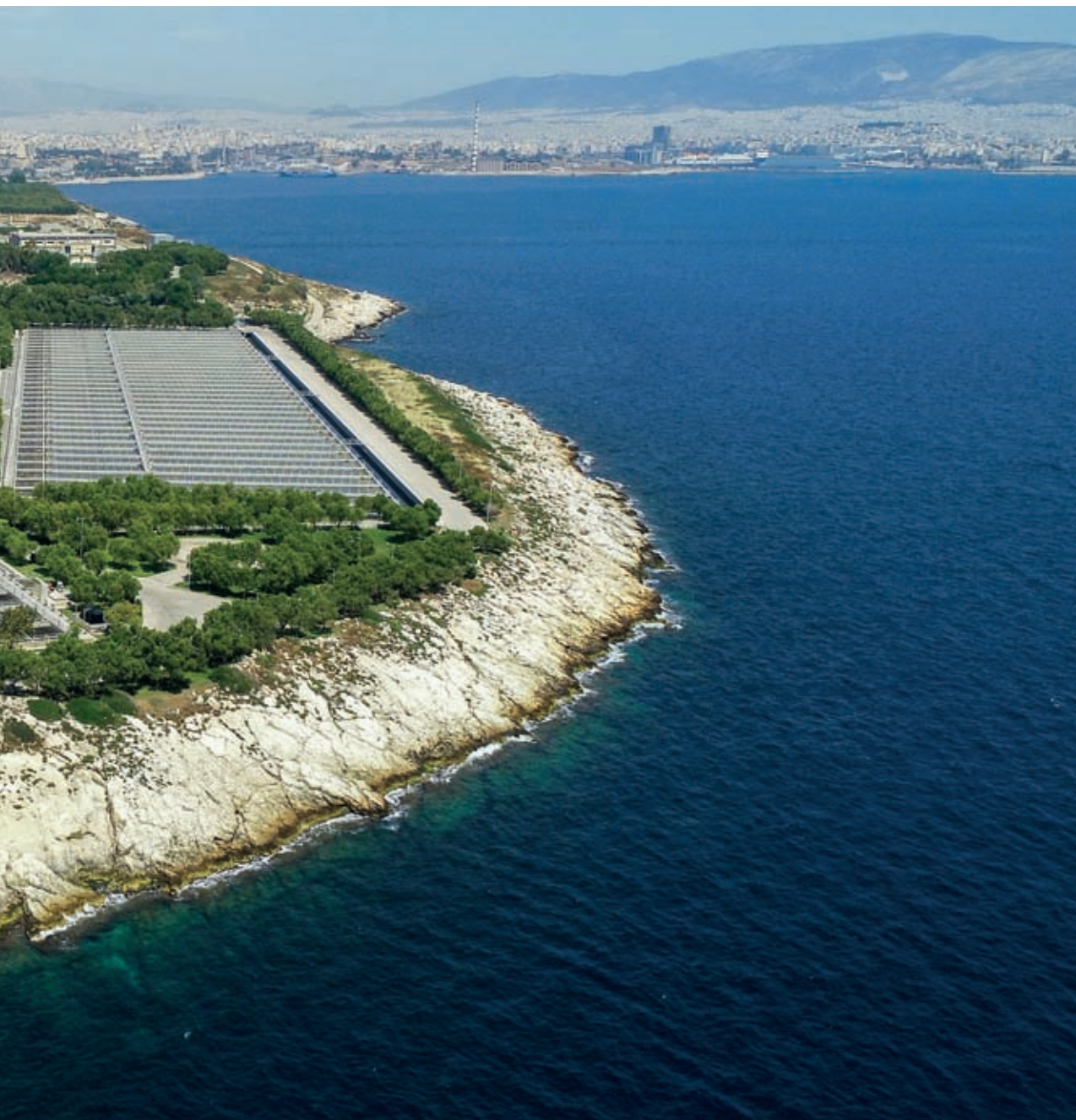
Το Κέντρο Επεξεργασίας Λυμάτων Ψυττάλειας. Στο μπροστινό μέρος απεικονίζονται οι Τελικές Δεξαμενές Καθίζησης. Πρόκειται για ένα από τα μεγαλύτερα ΚΕΛ στην Ευρώπη και διεθνώς, με δυνατότητα επεξεργασίας (μέση παροχή σχεδιασμού) 1.000.000 κ.μ./ημέρα λυμάτων
