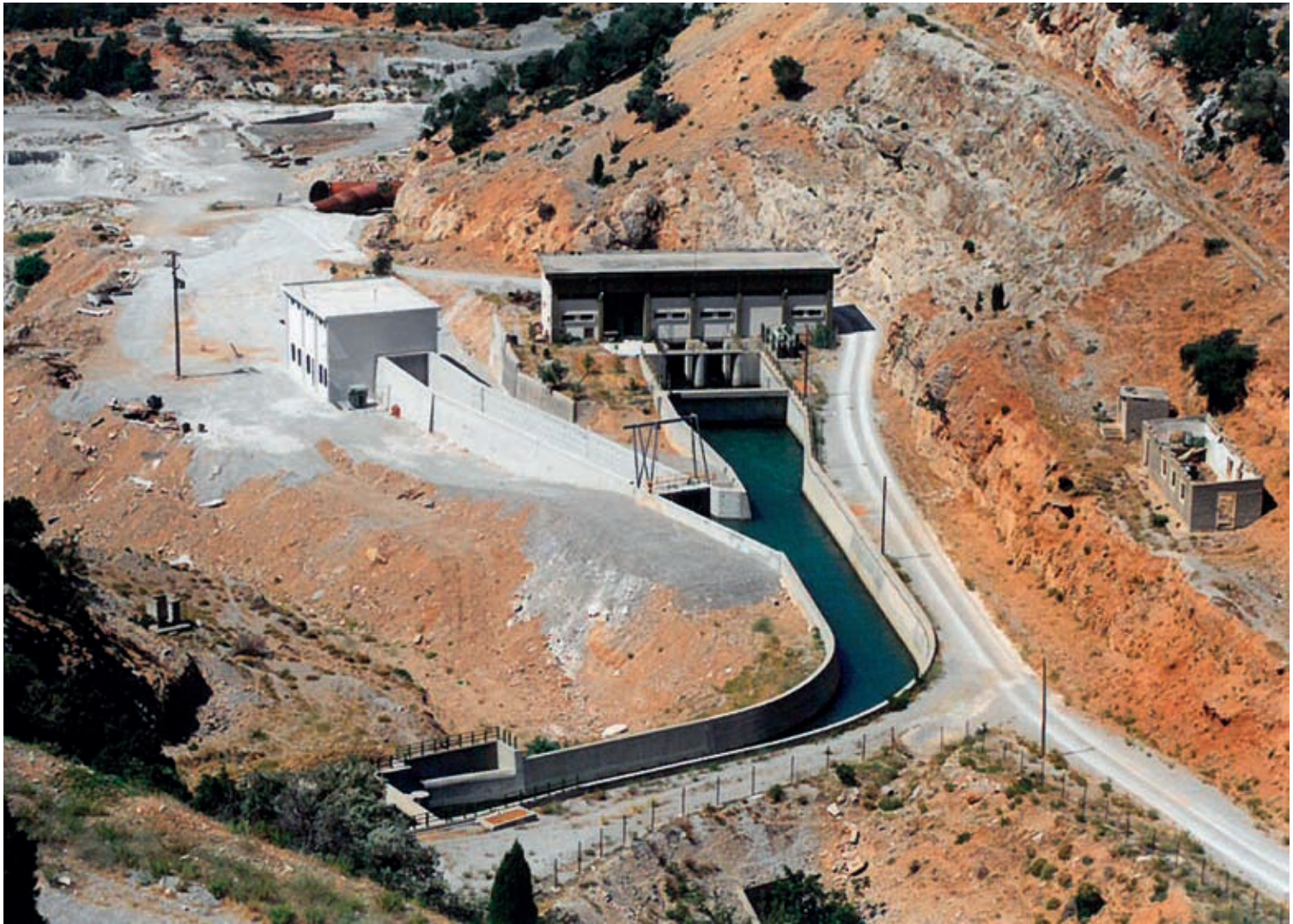
Μικρός Υδροηλεκτρικός Σταθμός Κίρφης. Παραγωγή ενέργειας από ανανεώσιμες και εναλλακτικές πηγές ενέργειας. Το νερό των υδραγωγείων εκτρέπεται σε κανάλι, όπου, με τη λειτουργία υδροστόβιλου, η υδραυλική ενέργεια μετατρέπεται σε μηχανική και, στη συνέχεια, μέσω γεννήτριας σε ηλεκτρική
