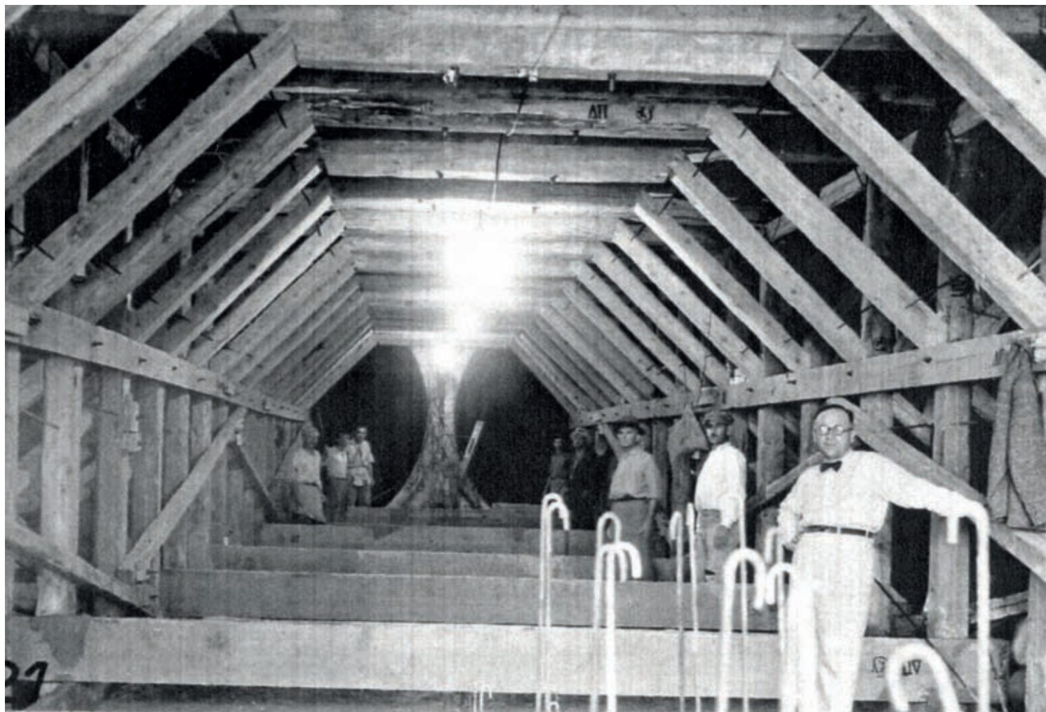
Ξυλότυπος του τεχνικού έργου ακαθάρτων στην Καισαριανή, 1940
